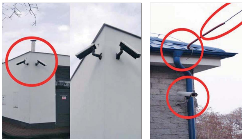
Obr. 2 Kamery jsou umístěny přímo v trase skrytých svodů
