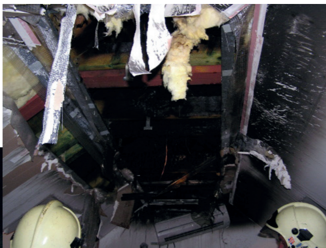
◀▲ Obr. 1: Požár hotelu, který byl způsoben bleskovým proudem o hodnotě 111 kA.
