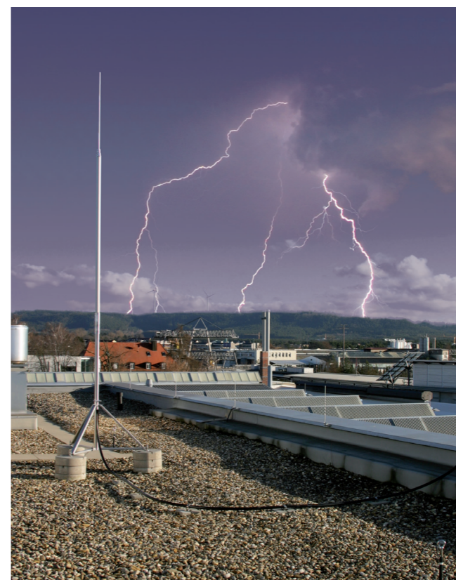
▲ Obr. 2: Instalace vodiče HVI power.
