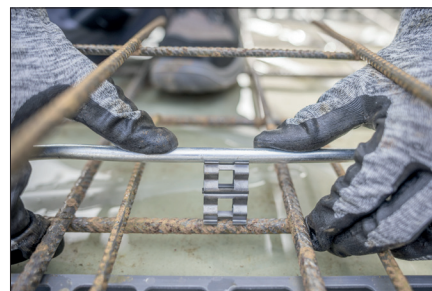
Obr. 6. Takto se DEHNclip používá
