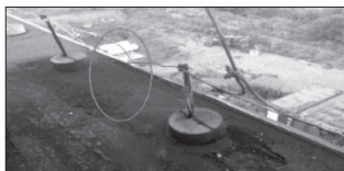
Obr. 1. Průraz bleskem izolovaného okružního vedení délky pouze 0,5 m
